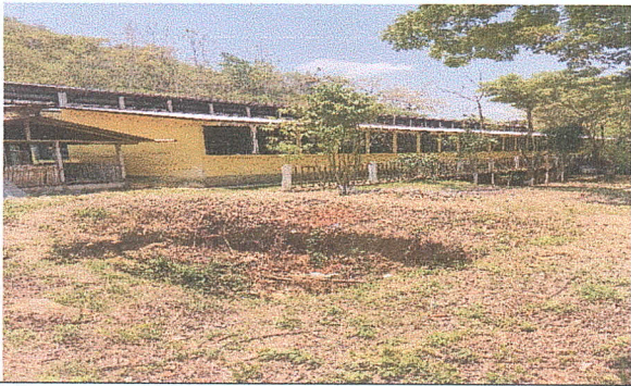
Foto 5: Reconstrucción de la fosa séptica.
