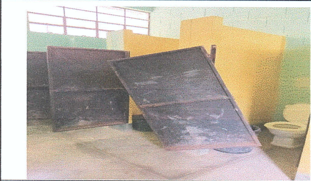
Foto1: Reparación de puertas de baños en mal estado.
