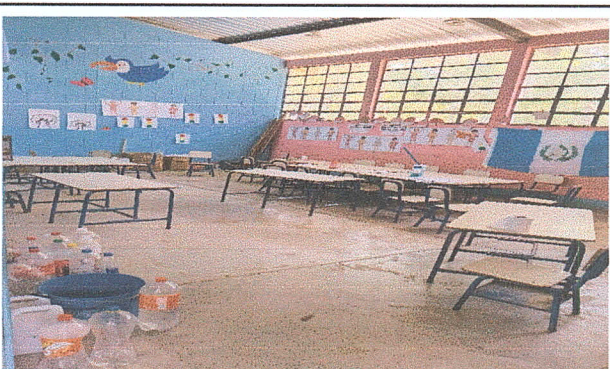
Foto 4: Colocación de Piso Cerámico en aula de preprimaria.
