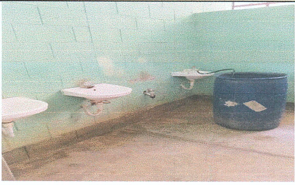
Foto 2: Fabricación y colocación de base de tinaco por desabastecimiento de agua potable.
